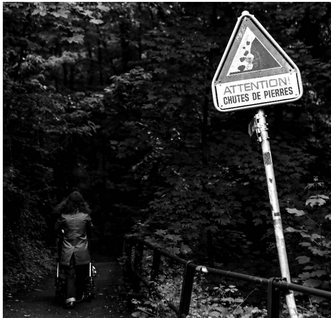
Les cheminements du bois de la Bâtie sont dégradés, voire fermés pour cause de danger. JPDS
